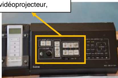
Commande EXTRON, pilote vidéoprojecteur,
